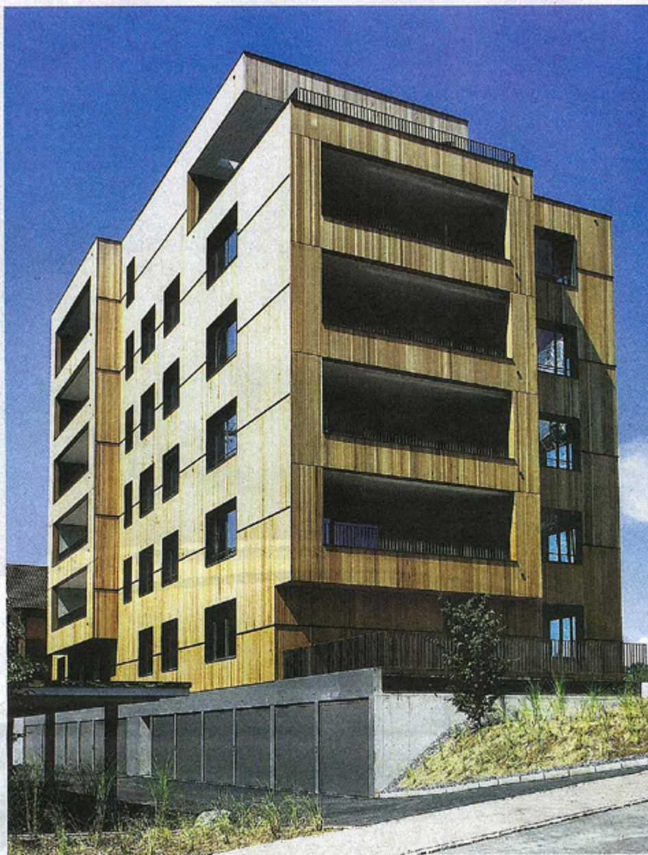
«Holzhausen» von den Luzerner Architekten Scheitlin Syfrig: Pionierbau im Minergiestandard
